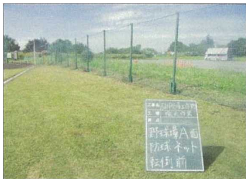
野球場の防球ネットは、洪水時に転倒可能とすること
