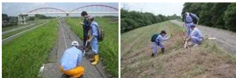
堤防点検（堤防の変状（亀裂、法崩れ等）把握）
