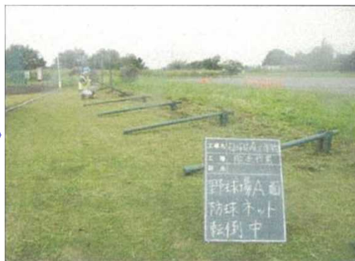
野球場の防球ネットは、洪水時に転倒可能とすること
