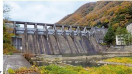
既設旭川ダム
