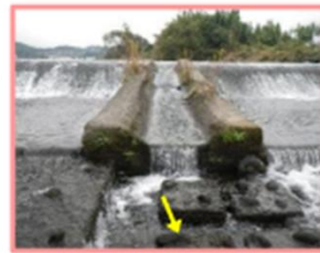
堰改築(撤去)により、上下流の連続性を確保
