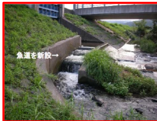
長田樋門の落差解消（県）
