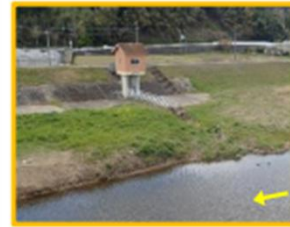
樋門改築により、本川と背後地の連続性を確保
