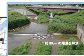
八代水門の落差改善(国)
