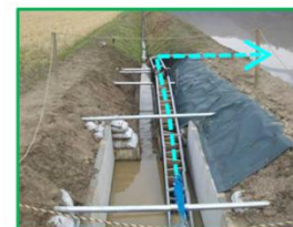
水田魚道の設置(県)
