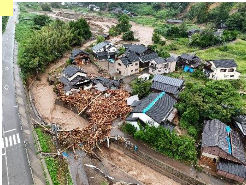
横断工作物(橋)に大量の流木が捕捉
