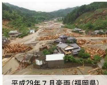
平成29年7月豪雨(福岡県) 土砂・洪水氾濫と同時に発生する流木による被害
