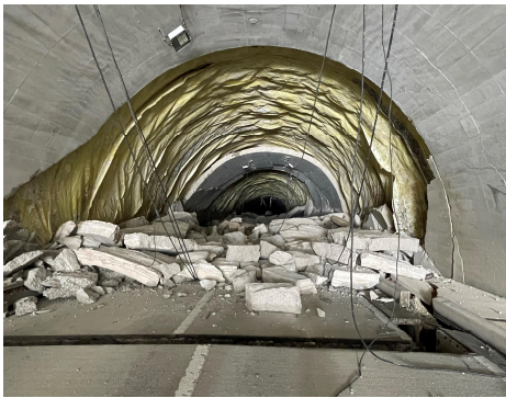
国道249号大谷トンネル(珠洲市)
