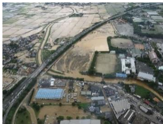
桂川における浸水被害
