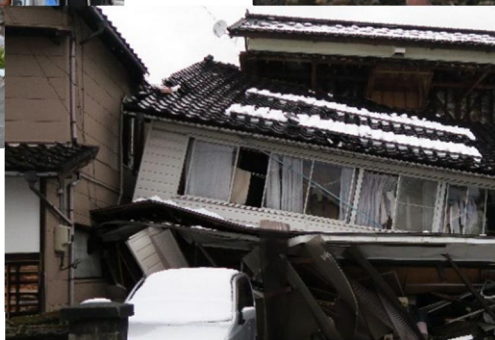
木造建築物の倒壊状況(穴水町)
