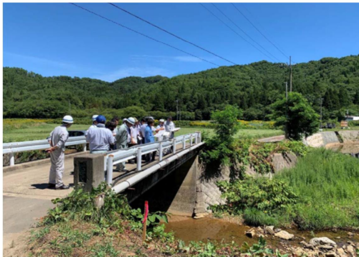
令和4年災 青森県脇野沢川 河川等災害関連事業
