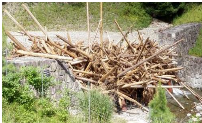
流木捕捉工(兵庫県宍粟市)
