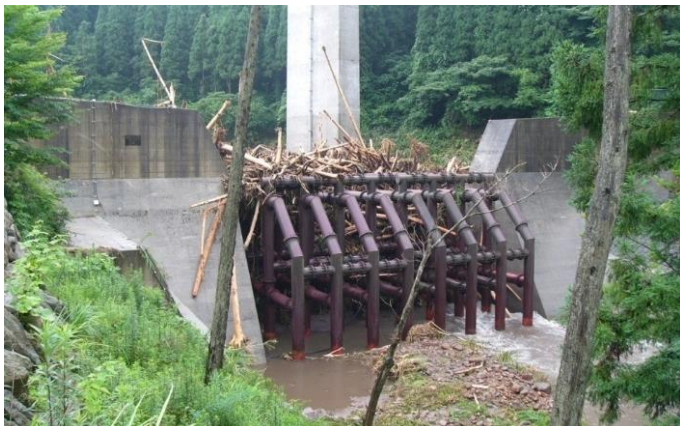
透過型砂防堰堤(熊本県小国町)
