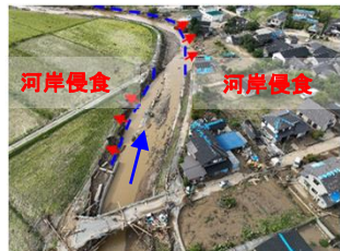
水衝部等の河岸侵食
