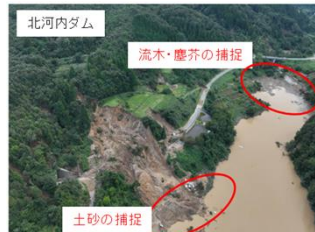
土砂・流木の捕捉にも効果的なダム
