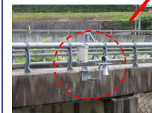
危機管理型水位計の設置
