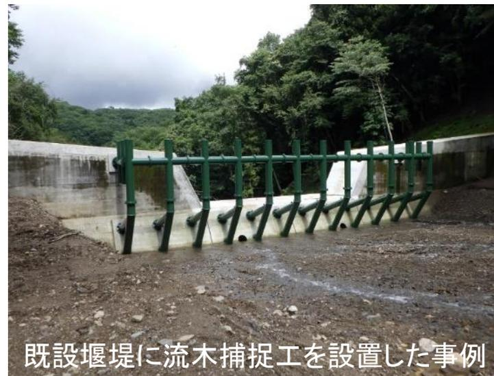
既設堰堤に流木捕捉工を設置した事例
