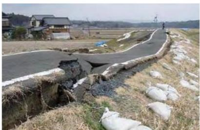
堤防の変状(決壊、沈下、亀裂)や流下能力の低下
