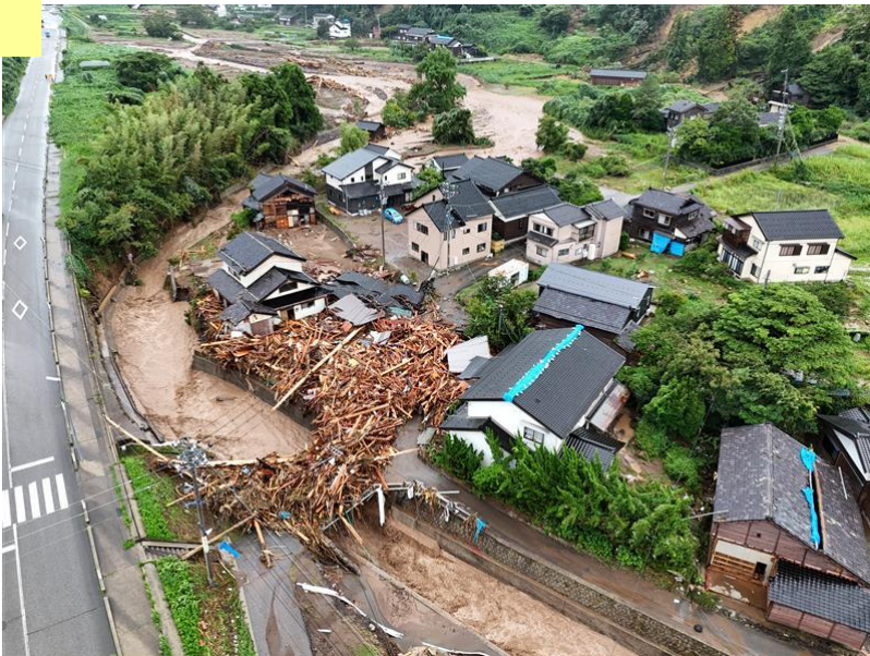
横断工作物 (橋) に大量の流木が捕捉
