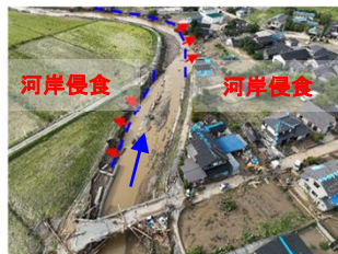
水衝部等の河岸侵食
