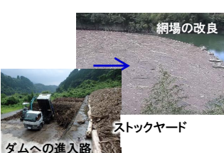
ダムへの進入路、ストックヤード、流木の早期撤去を図る施設の整備
