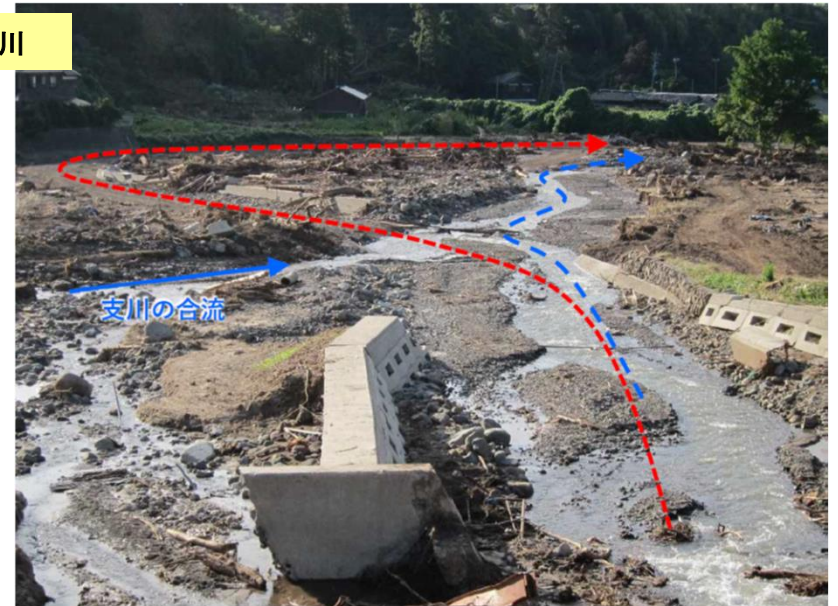
流木、土砂を含む洪水により流路が変更 (ショートカット)
