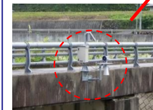
危機管理型水位計の設置
