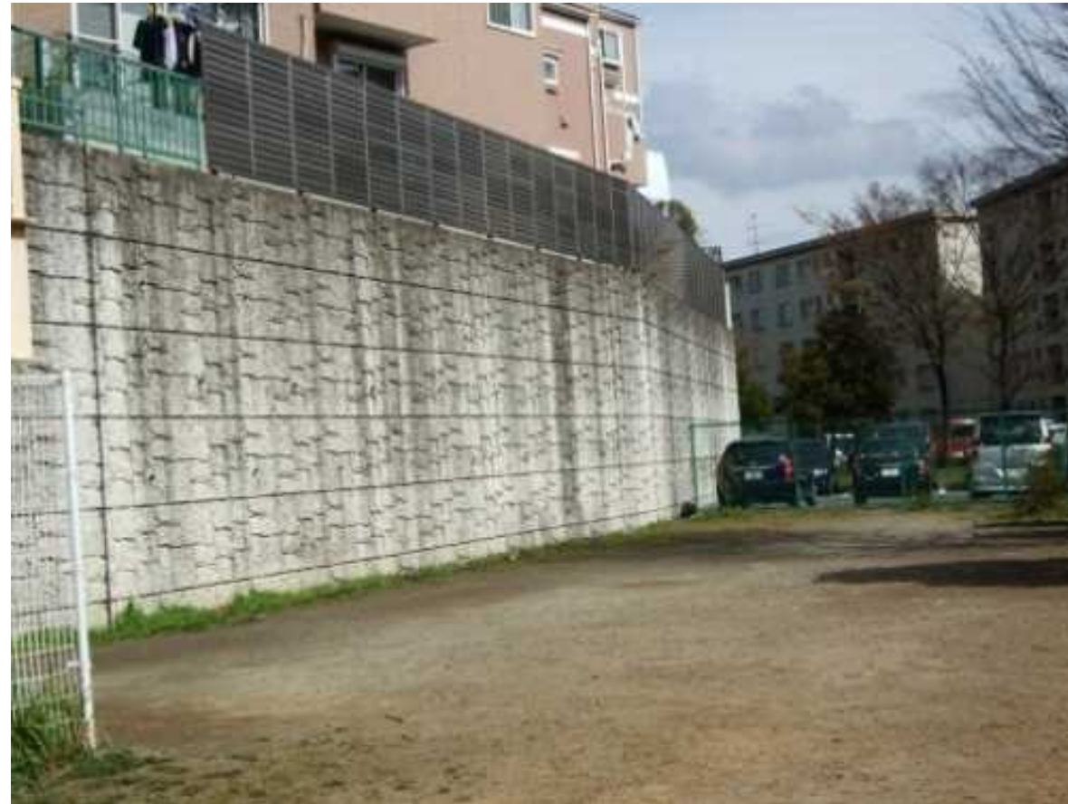
盛土端部の処理として擁壁を整備した事例
