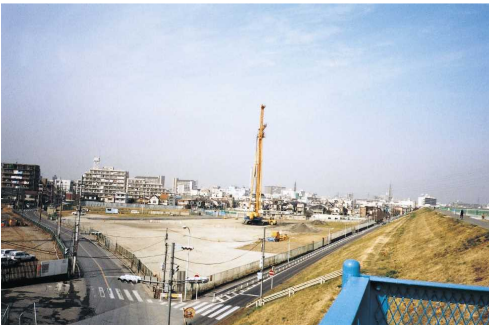
工場が撤去され高規格堤防の盛土等に着手した新田地区
