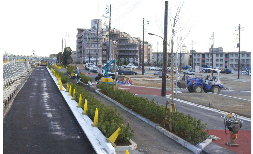
高規格堤防の盛土が完了し、整備が進む街区
