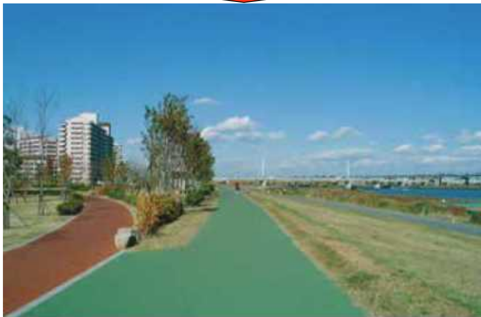
高規格堤防の整備によって堤内地側は堤防とほぼ同じ高さに盛土
