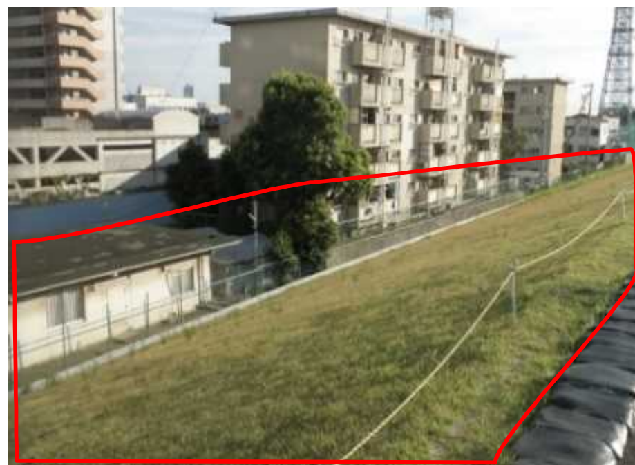
現在の堤防の堤内地側の状況
