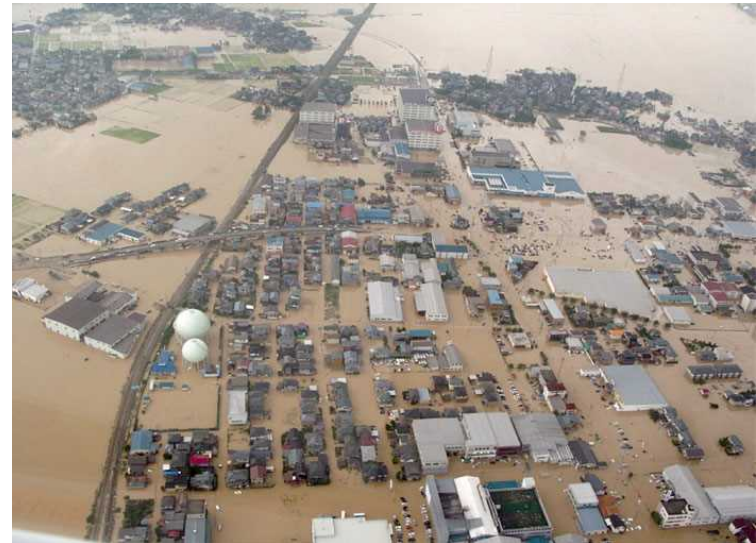
新潟・福島豪雨水害時 (H16.7: 新潟県三条市) の浸水状況
