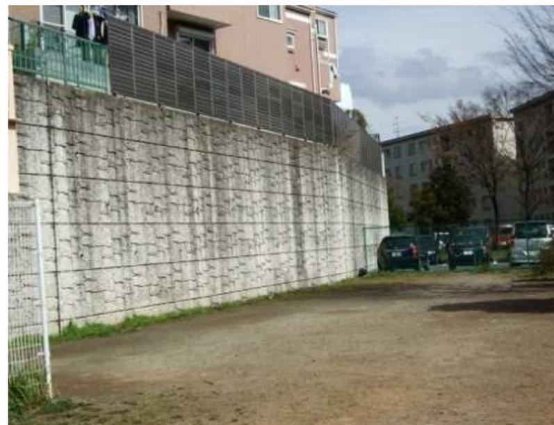
盛土端部の処理として擁壁を整備した事例
