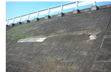
護岸ブロックの破損状況
