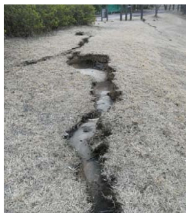
②法面すべり
