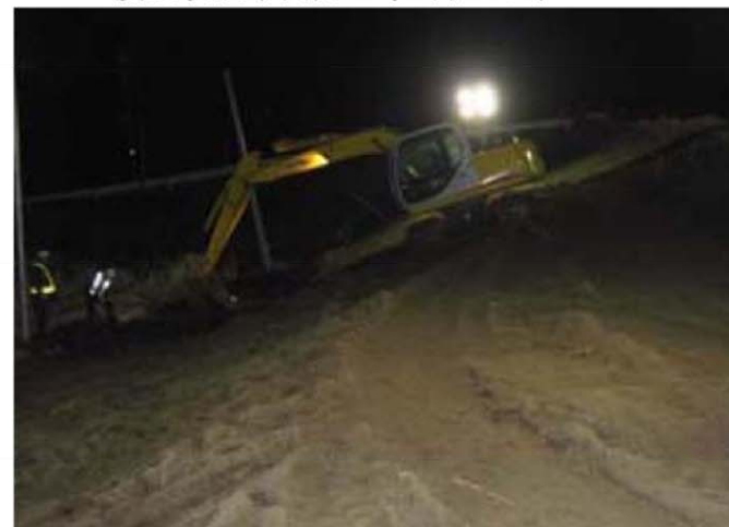
復旧状況(平成23年3月26日)
