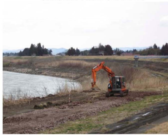
復旧状況(平成23年3月26日)
