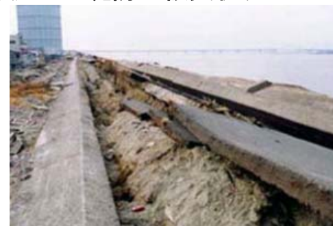
阪神・淡路大震災における淀川の堤防の被災状況
