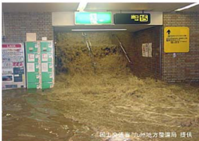
平成15年 地下街の浸水状況(福岡県)
