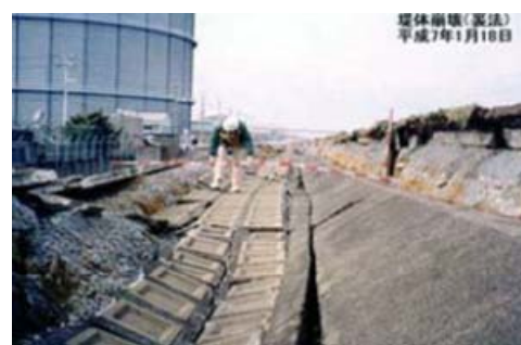
阪神・淡路大震災における淀川の堤防の被災状況
