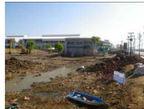
排水後の状況(11月27日)
