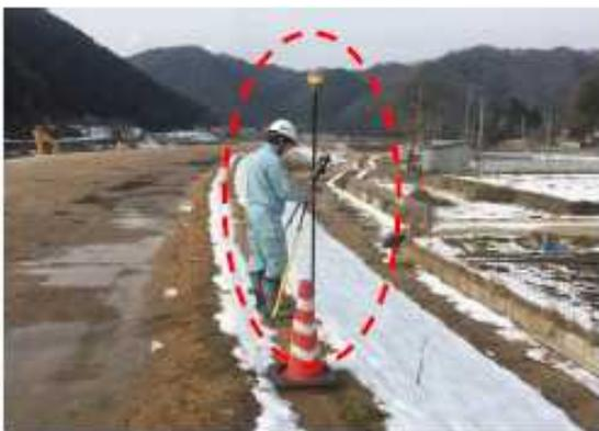
GNSSローバーを用いた出来形計測
