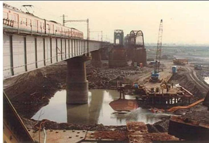
橋脚周辺の局所洗掘による落橋事例
