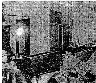
天井近くまで浸水し家具などが散乱した地下1階の倉庫 —東京都新宿区西落合で21日午後6時すぎ、竹内幹写真
