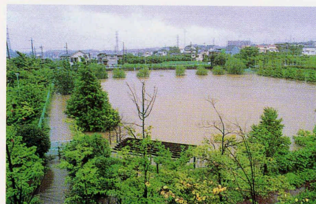
洪水時は洪水を貯留（平成3年9月、台風18号）
