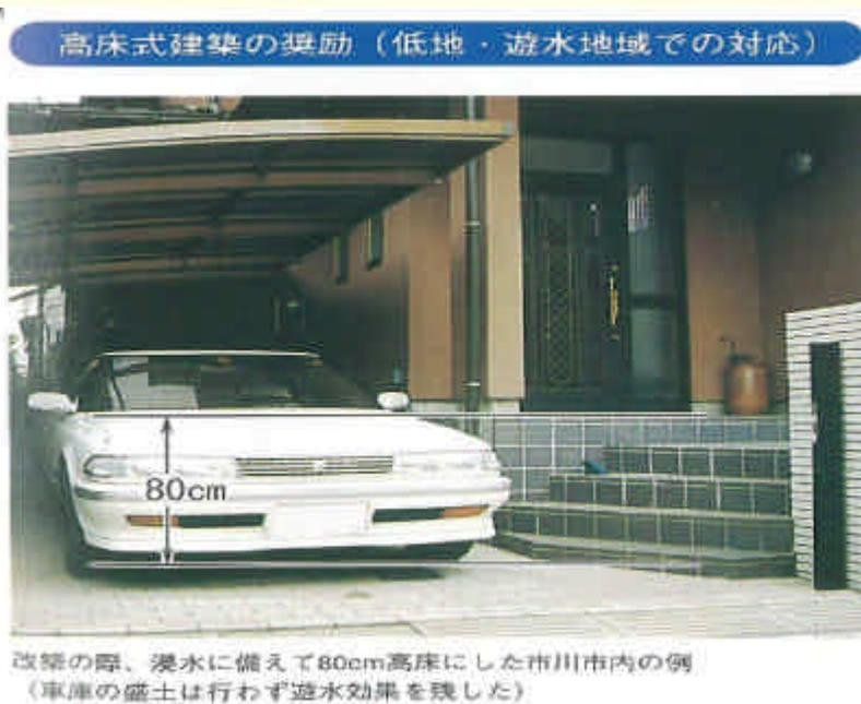
鶴見川の近くに住んでいるため過去の経験を生かし、洪水時に被害がないようピロティ構造とした
