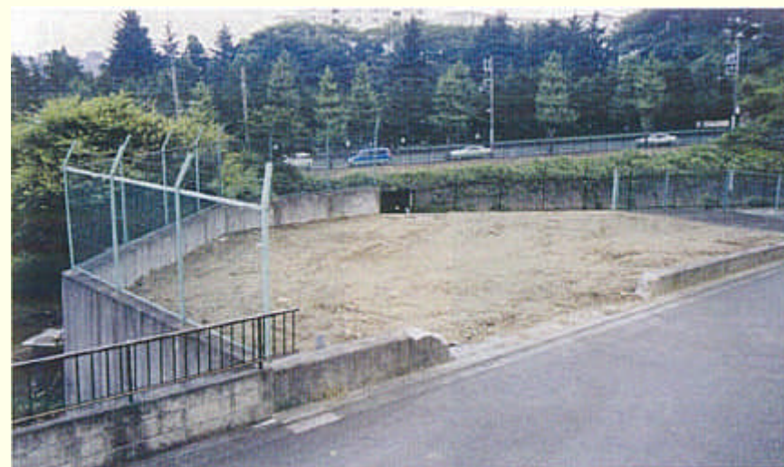
埋められた調整池の例(鶴見川)
