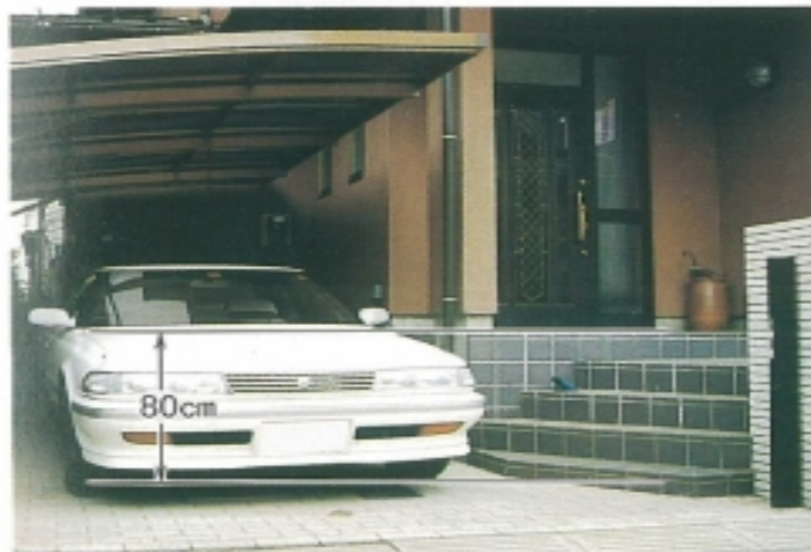
改装の際、浸水に備えて80cm高床にした市川市内の例 (車庫の盛土は行わず遊水効果を残した)
