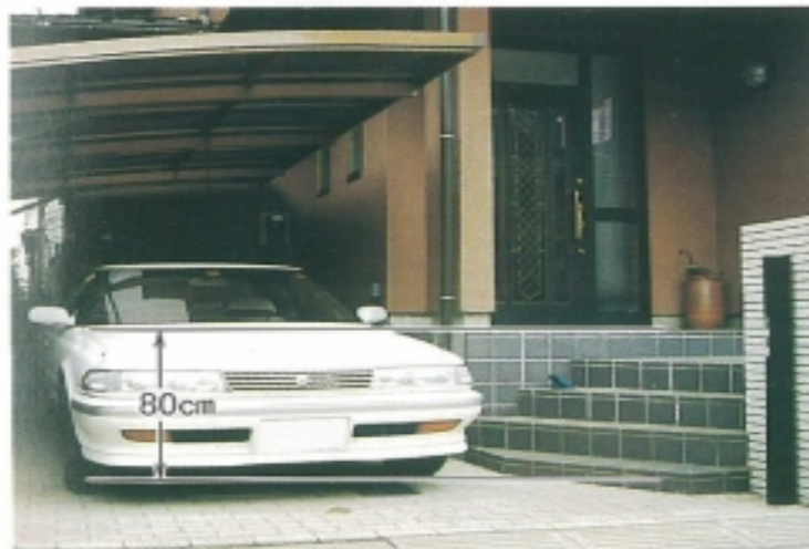
改装の際、浸水に備えて80cm高床にした市川市内の例 (車庫の盛土は行わず遊水効果を残した)
