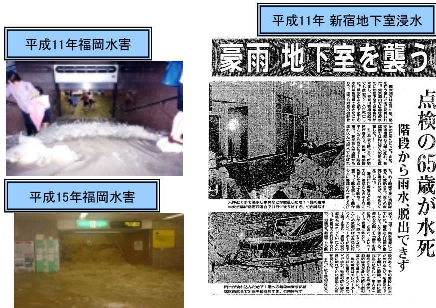
図 6-4 地下空間での被害
