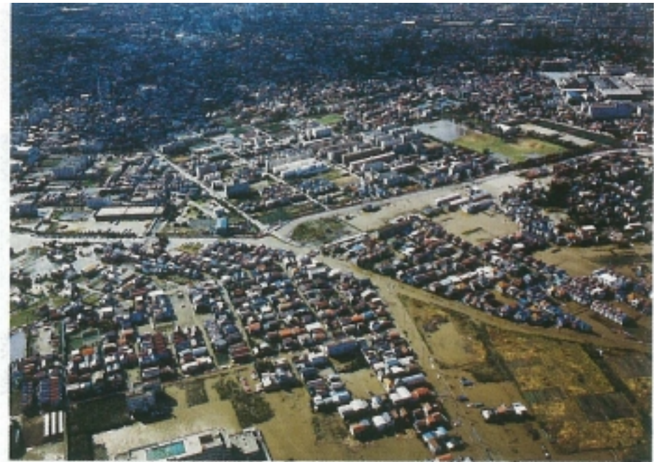
台風24号の出水 (真間川・昭和56年10月)
