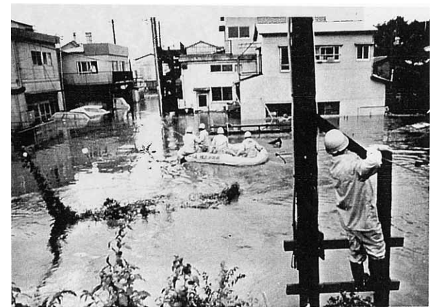
大熊川の破堤による湛水
