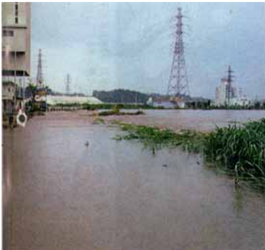
太尾地点における本川からの越水 (右側、鶴見川本川)
