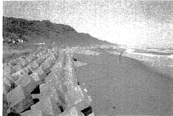
■沿岸方向に長く続く消波ブロック 崖崩落防止あるいは護岸防護のための消波ブロックが砂浜からの避難時の障害となる 事例－表浜海岸（渥美半島）
