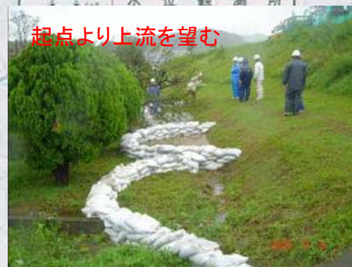
水防活動(漏水対応)
