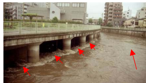
参考: 地下調節池流入状況 (H15撮影)
