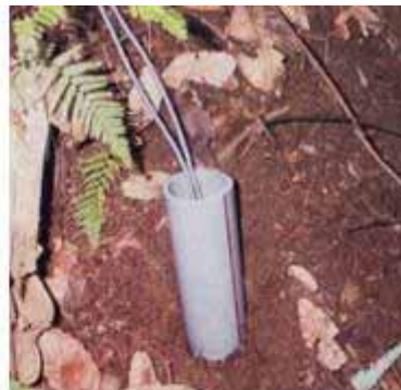
傾斜計の設置例
