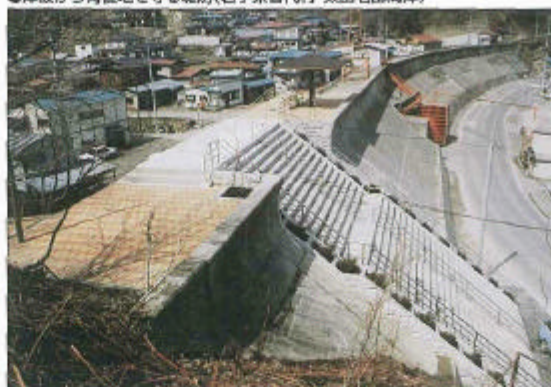
●津波から背後地を守る堤防(岩手県菅代村 太田名部海岸)
