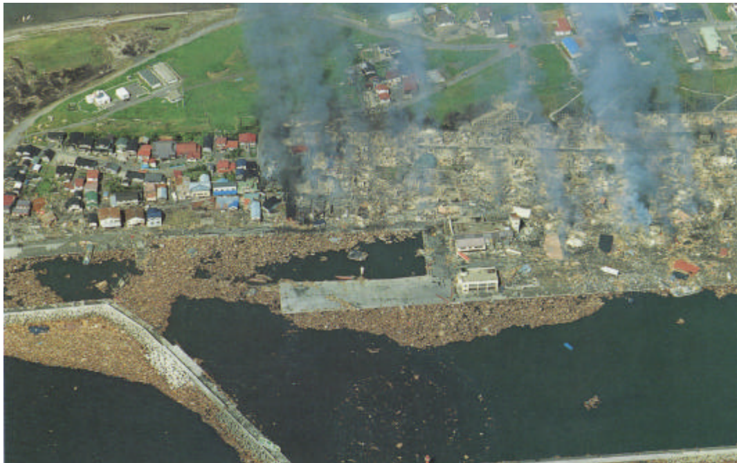
北海道南西沖地震津波による被害（平成7年／北海道奥尻町青苗地区）
