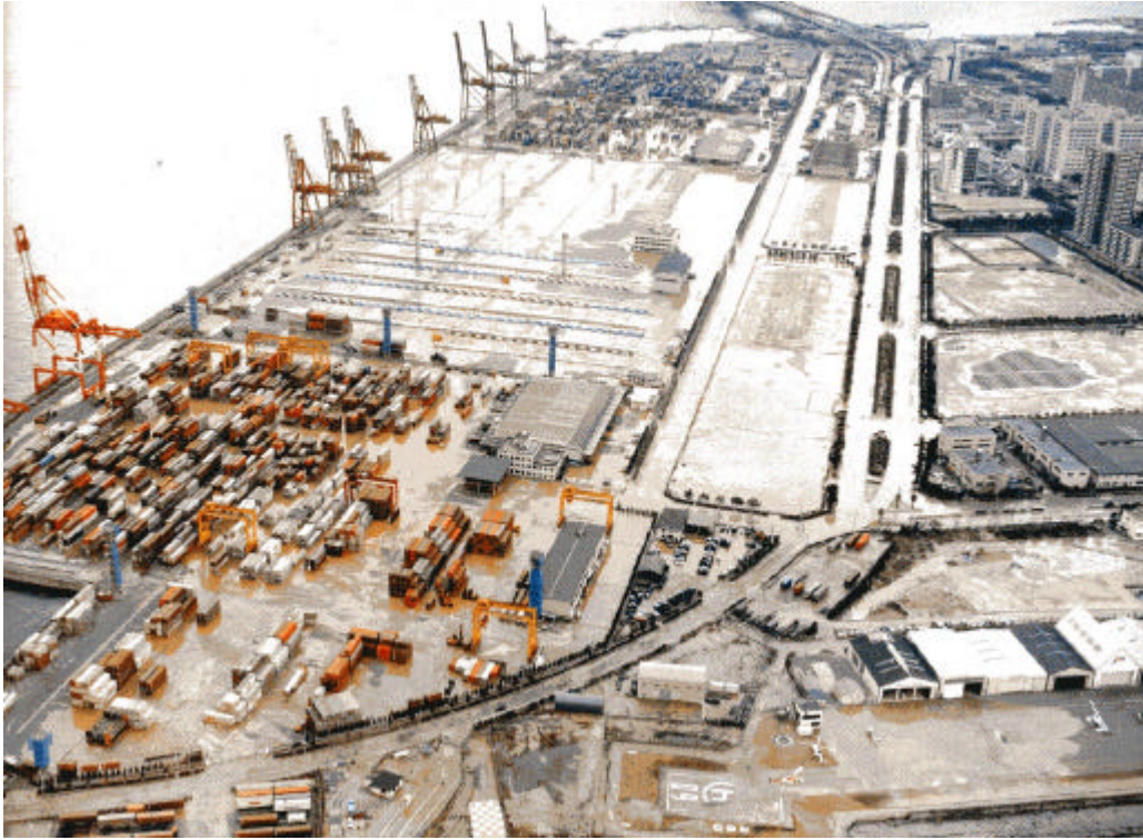
阪神 淡路大震災により、神戸港ポートアイランドに発生した液状化による噴砂現象
