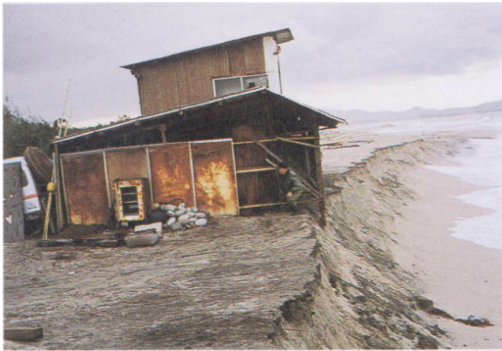
海岸侵食による浜崖：鳥取県米子市皆生海岸
