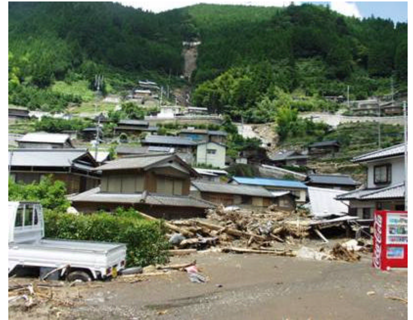
徳島県那賀郡上那賀町白石 (全壊5戸、半壊2戸、一部損壊3戸)
