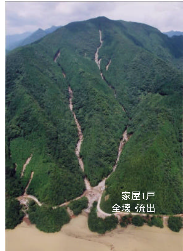
大川村舟戸加茂次郎谷崩壊状況
