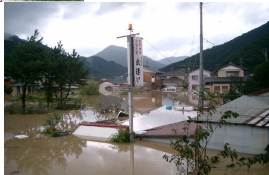
二級河川銚子川・船津川漫水状況 (三重県海山町)
