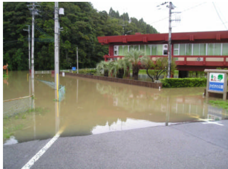
浸水状況（夷隅町）
