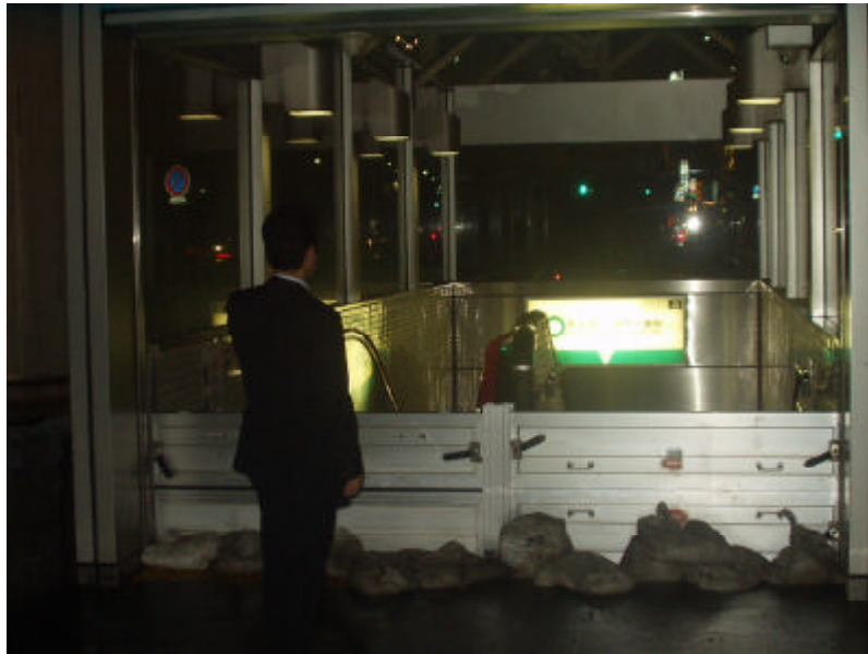
東京地下鉄麻布十番駅（東京都港区）
