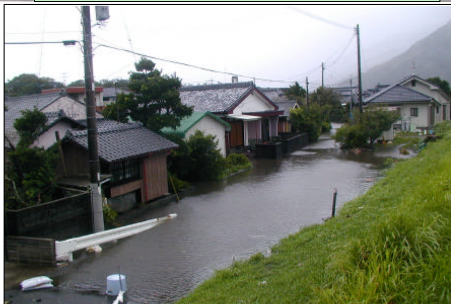
浸水状況 (肝属川水系汐入川 鹿児島県東串良町)
