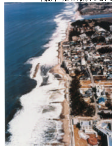
離岸堤整備による砂浜の保全（鳥取県皆生海岸）
