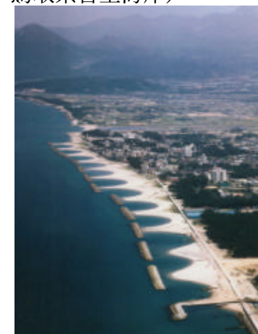
離岸堤整備による砂浜の保全（鳥取県皆生海岸）
