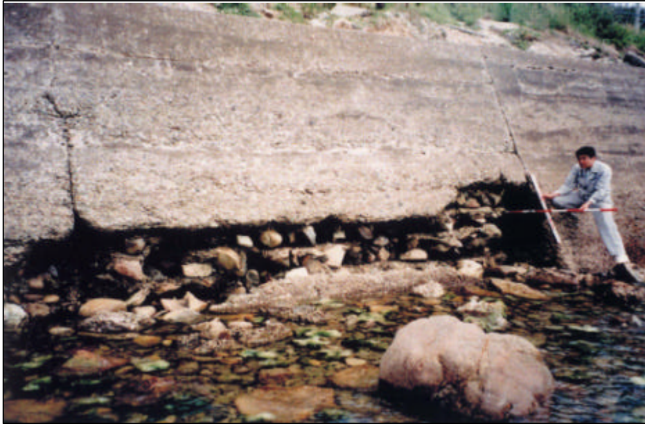
老朽化した護岸の状況（兵庫県阿那賀海岸）
