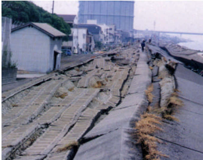
地震による堤防の被災状況
