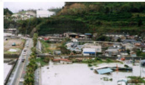
高潮による被害 平成 11年台風 18号による被害 (熊本県不知火町)
