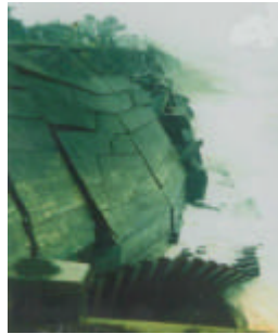
海岸侵食の進行による 堤防の被災例 (高知県高知海岸)
