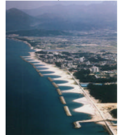
離岸堤整備による砂浜の保全 (鳥取県皆生海岸)
