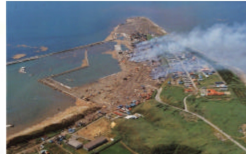
津波による被害 平成 5年北海道南西沖地震津波による被害 (北海道奥尻町)
