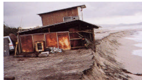
侵食による被害 冬季風浪による海岸侵食 (鳥取県皆生海岸)
