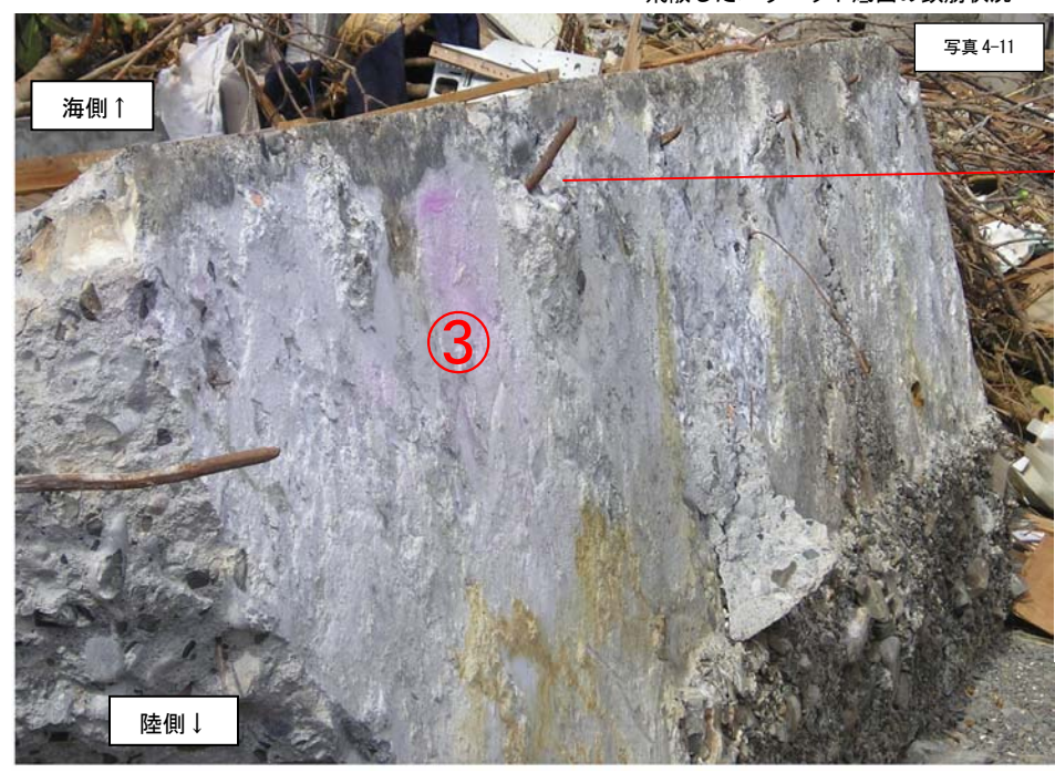
飛散したパラペット底面の鉄筋状況
