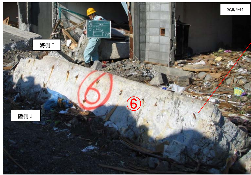
飛散したパラペット底面の鉄筋状況
