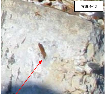
飛散したパラペット底面の鉄筋状況
