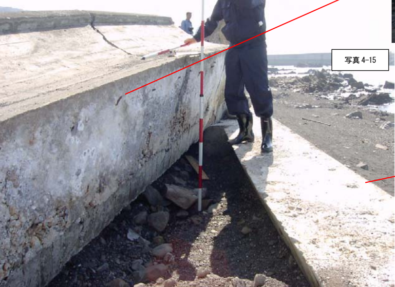
被災箇所南側端部のパラペット及び堤体打継目状況
