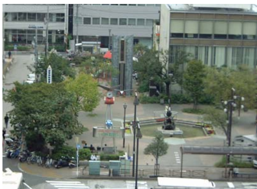
亀井戸駅前の荒川水位塔設置状況
