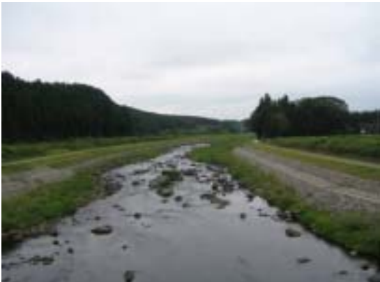
手直し工事後の経過（平成 17 年）
