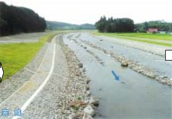
災害復旧工事の完成後（平成 13 年）
