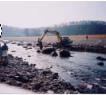
手直し工事（平成 14 年）
