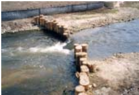
改修直後のウェッジダム
