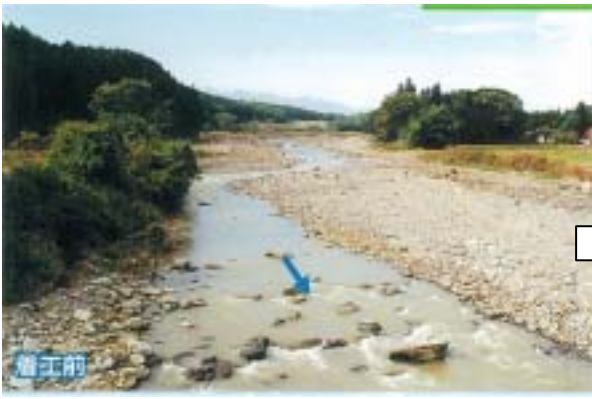
災害復旧工事の着工前（平成 10 年）
