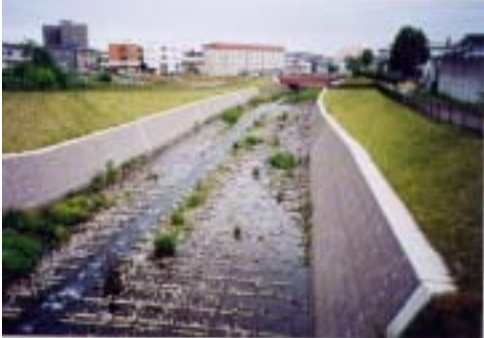
施工後（平成 14 年 6 月）
