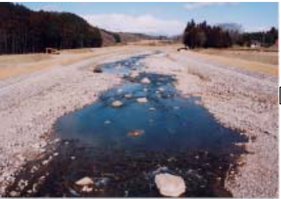
手直し工事後（平成 14 年）
