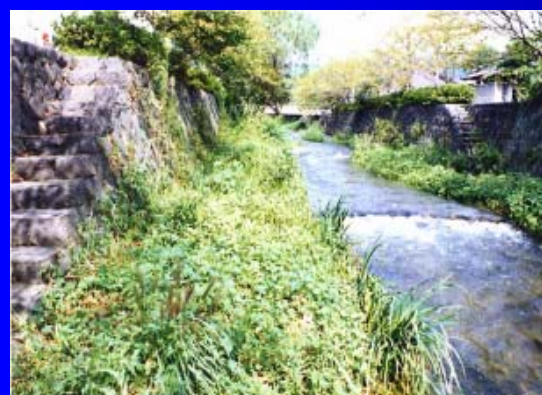
一の坂川（山口県）のホタル護岸 （昭和47年度施工）
