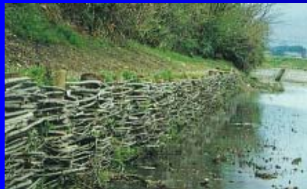
堤沢川（新潟県）の粗朶柵工 （平成3年度施工）
