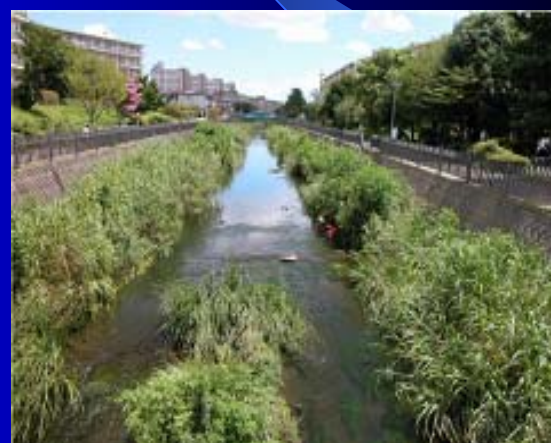
いたち川（神奈川県）の低水路 （昭和57年度施工）
