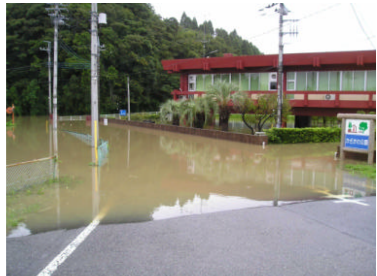
浸水状況（夷隅町）
