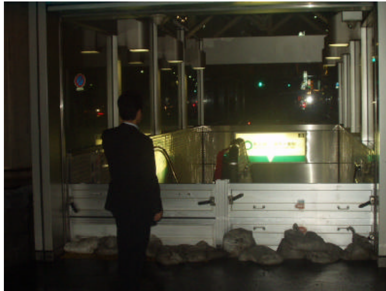
東京地下鉄麻布十番駅（東京都港区）
