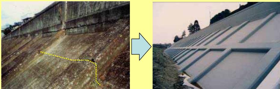
河床低下による護岸の根固め損傷
