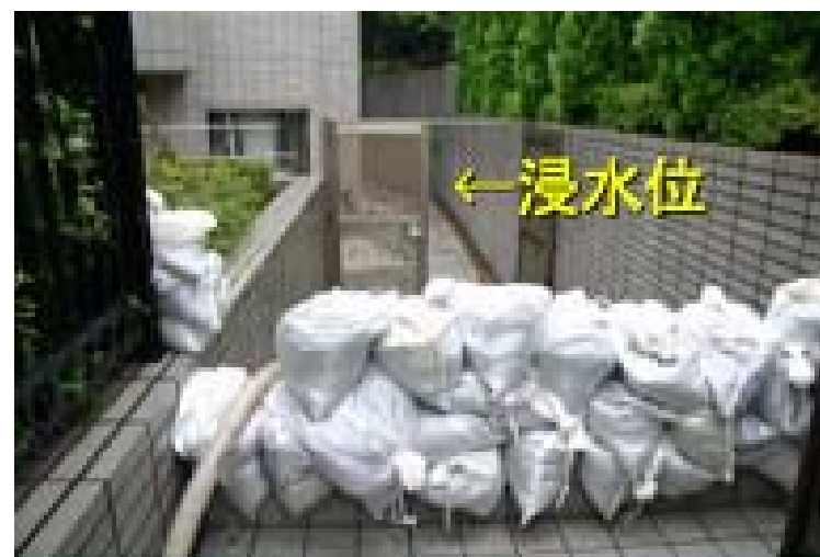
土嚢の常備 出水前の土嚢設置
