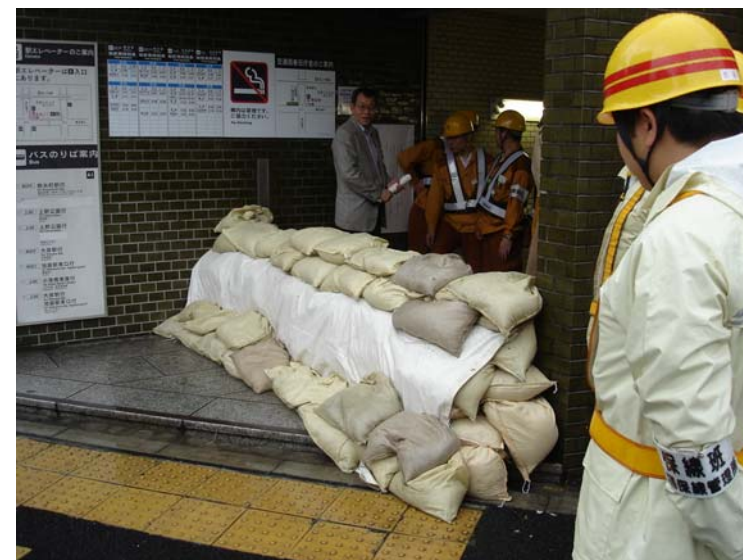
土嚢と防水シートによる対策(地下鉄)
