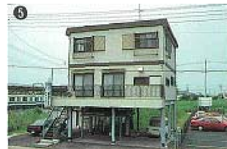
ピロティー建築による耐水化(中川・綾瀬流域)
