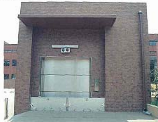
止水板の設置(鶴見川流域)
