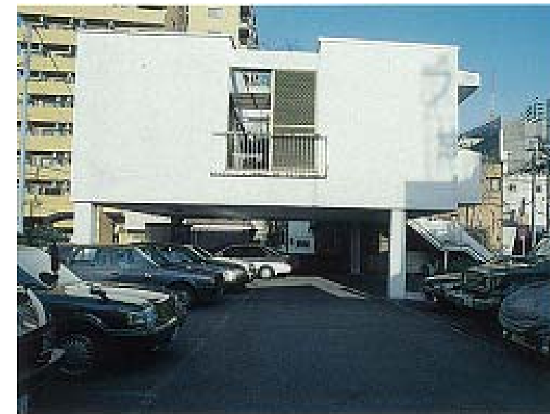
ピロティー建築による耐水化(鶴見川流域)
