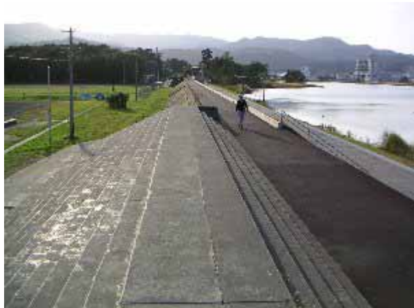
避難に資するため、堤防に階段を設置した例
