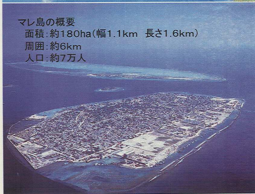
マレ島を囲む護岸及び離岸堤
