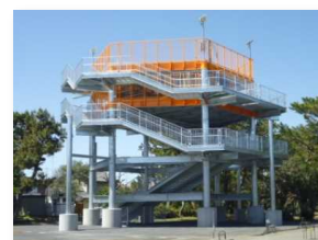
津波避難タワー
