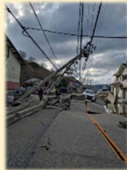
電柱倒壊等による道路閉塞
