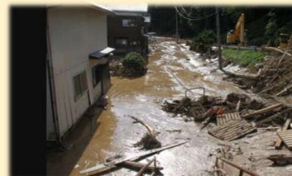
浸水被害にあった家屋(珠洲市)
