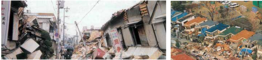
道路沿道建築物の倒壊による道路閉塞の事例（平成7年阪神淡路大震災）
