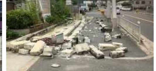
ブロック塀等の倒壊による 道路閉塞の事例 （平成30年大阪北部地震）
