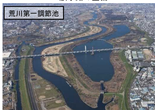
洪水調節施設の整備
