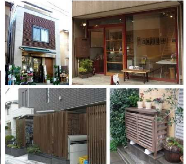
木の素材感を意識したファサード、格子による目隠し、軒先の 緑などによる風情ある街並みの演出
