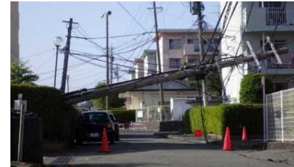
電柱の倒壊による道路閉塞の事例 （平成28年熊本地震）
