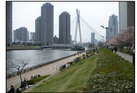
スーパー堤防の整備(隅田川:新川地区)
