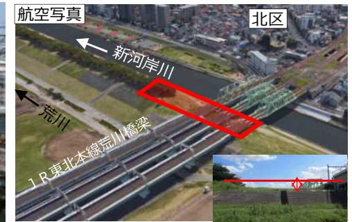
JR東北本線橋梁部周辺対策
