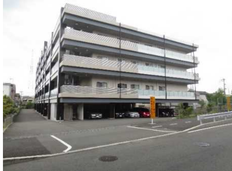
建築物のピロティ化(大阪府堺市)
