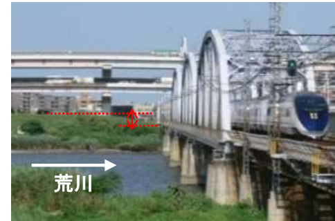
京成本線荒川橋梁架替
